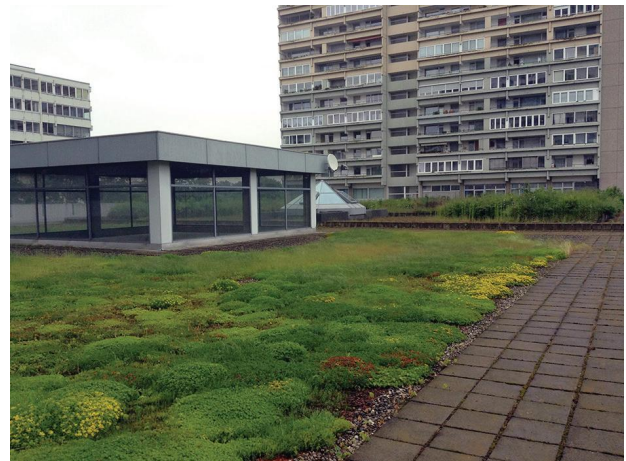
Abb. 6: Dachfläche Schwabencenter Mitte
