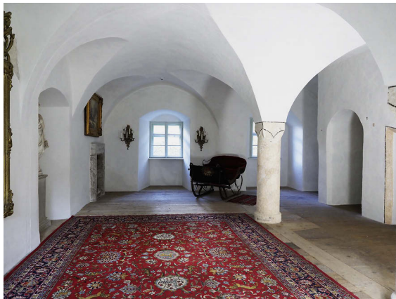
19 Raum über dem mittleren Raum im Erdgeschoss mit Mittelstützen an gleicher Stelle.
