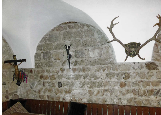
6 Nordöstlicher, leicht eingetiefter Kellerraum. Ansicht der Westwand von Westen.
