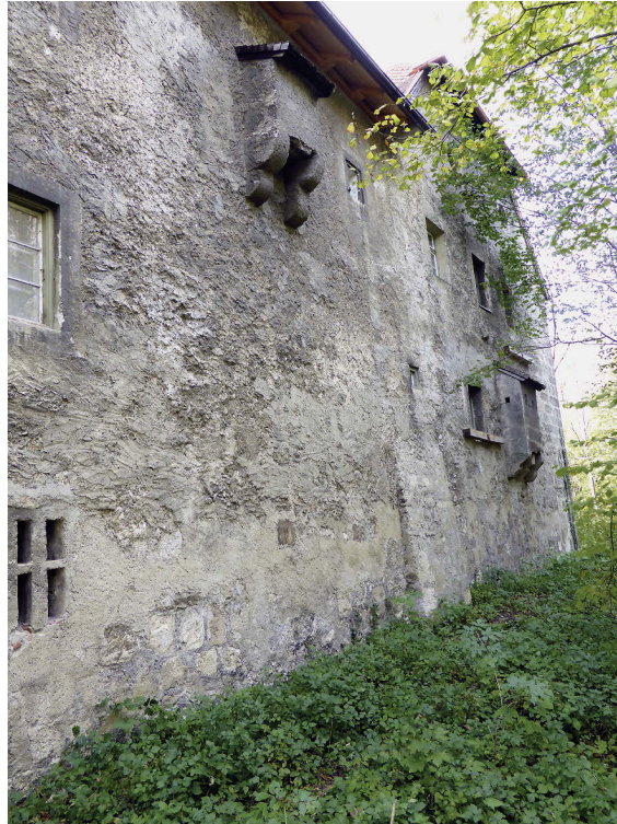
13 Östliche Ringmauer mit den beiden Abortkernen.
