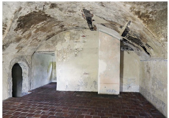
17 1. OG, an den Palas angrenzender Raum im Ostflügel nach der Instandsetzung. Links die Tür zum Palas. Im Gewölbe sind die Balken der ehemaligen Esse noch sichtbar.
