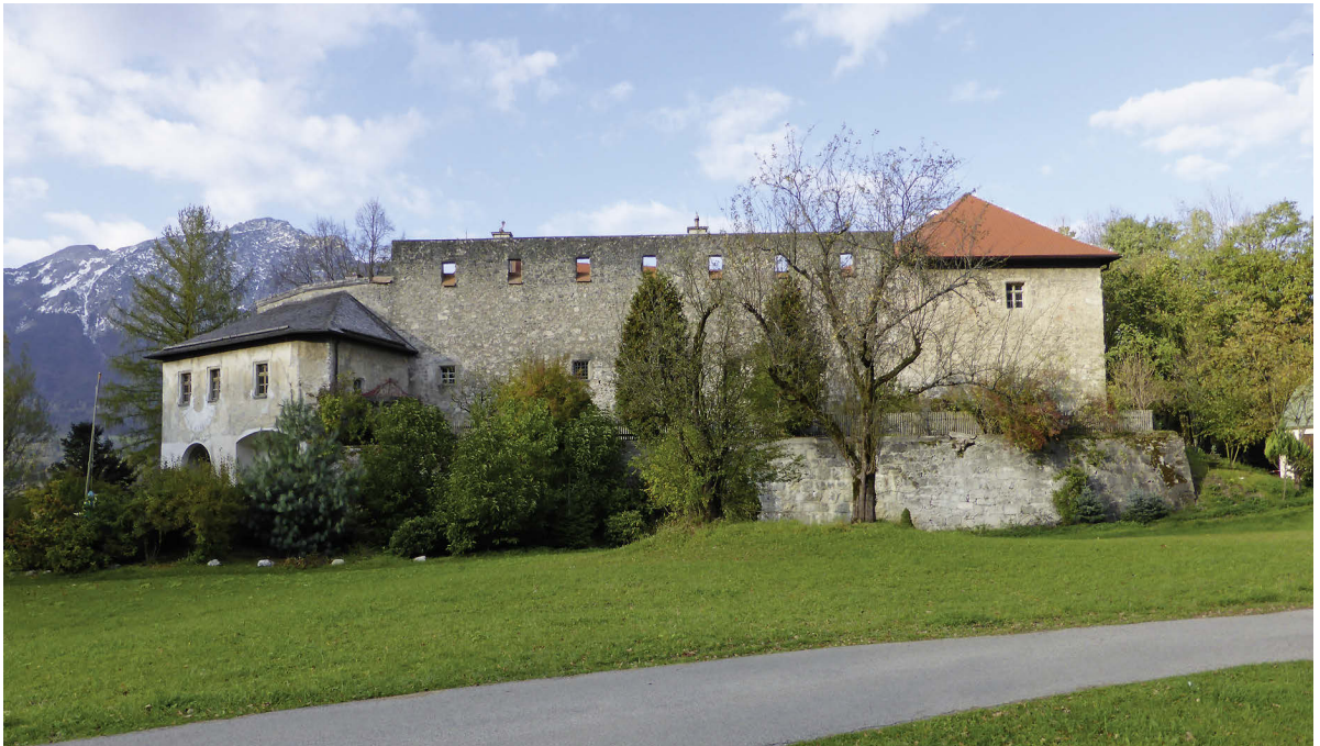
1 Burg Gruttenstein, Ansicht von Süden.
