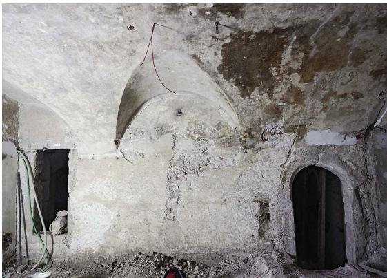
16 1. OG, an den Palas angrenzender Raum im Ostflügel. Rechts im Bild die romanische Tür mit Rundbogen und links das Fenstergewände.
