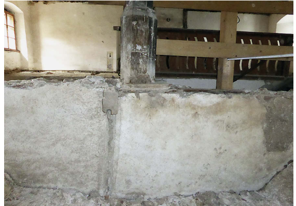
15 2. OG, Mittelstütze im Saal. Seitlich an der Mittelstütze der Rähm mit Nut.
