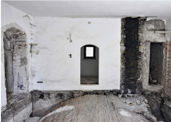
14 An den Palas angrenzender Raum im Ostflügel. 2. OG mit freigelegten Balkenlöchern und Gewölbe. Rechts der Zugang zum Aborterker.
