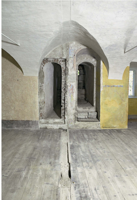
21 Geteilter Aborterker im 1. Obergeschoss in der Ostwand.
