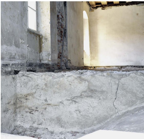
11 Saal im 2. Obergeschoss mit der Zwischenwand aus dem 1. Obergeschoss. Blick nach Westen.
