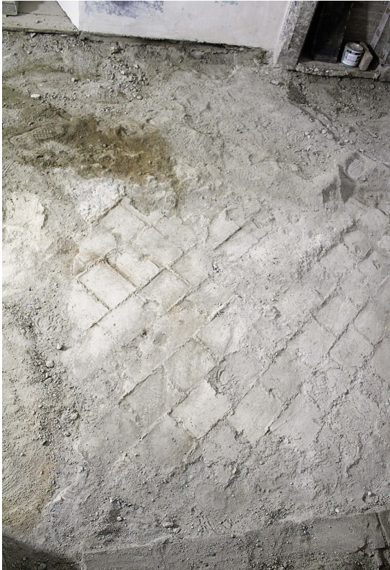
20 Westlicher Raum. Abdrücke eines Backsteinfußbodens im Estrich.
