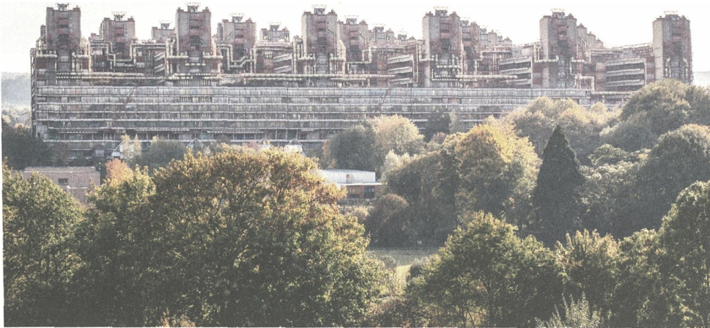
Abb. 9 Universitätsklinikum der RWTH Aachen, Nordansicht
