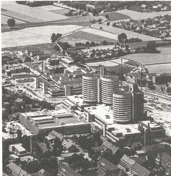
Abb. 6 Baustelle des Universitätsklinikums Münster, 1976
