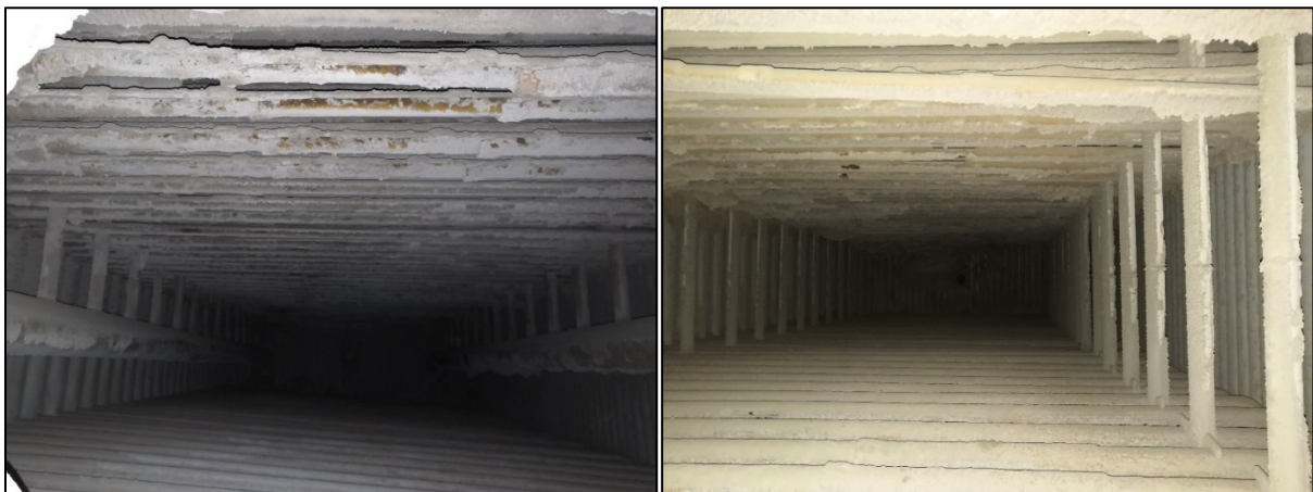
Abbildung 23: Blick auf die Messpositionen MVV Gersthofen während Revision (nach Abschaltung unter vorangegangener Sprengreinigung), (a) 17,5m zwischen Verdampfer 1 (unten) und Überhitzer 2 (oben) und (b) 21m zwischen Überhitzer 2 (unten) und ÜH 1.1. (oben), die Probenahmelanze wurde durch den mittig im Mannlochdeckel sitzenden Stützen, d. h. auch mittig zwischen den Rohrpaketen 170cm tief eingebracht
