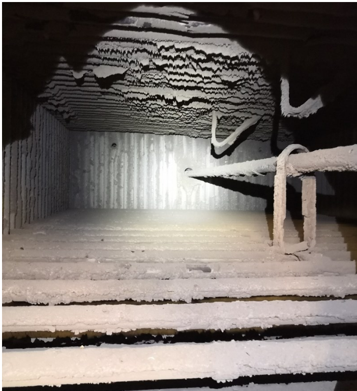
Abbildung 17: Sicht durch Mannloch in den 3. Zug, Linie 12 GKS, 20,5m ÜH4 von unten, ÜH6 von oben, Oktober 2021
