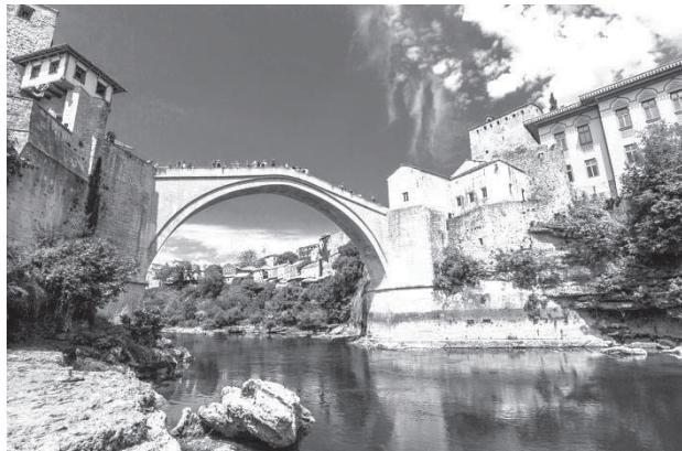
Die Brücke heißt Stari Most was auf Deutsch „alte Brücke“ bedeutet. Sie ist eine Bogenbrücke und wurde aus Stein gebaut.
