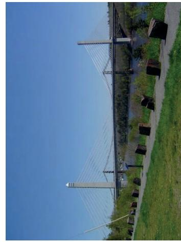
Auslegerbrücke mit Schrägselikonstruktion
