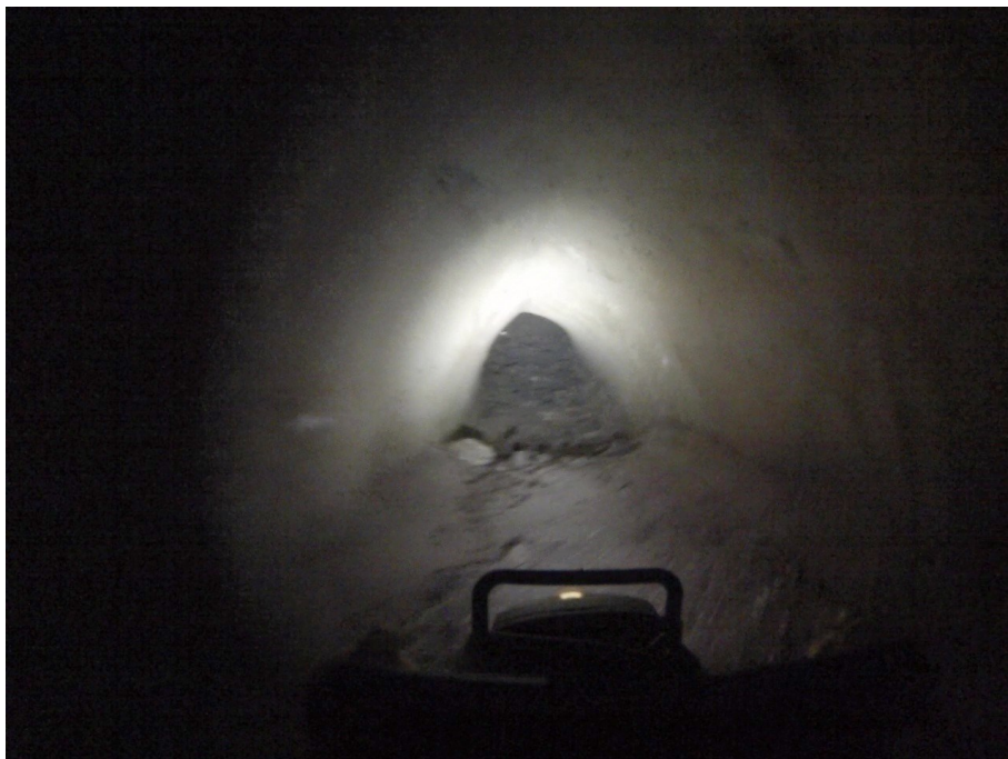
Abb. 17: Standbild der Videokamera aus dem ersten Seitengang. Das Fahrzeug befindet sich in der Schlussröhre; die Fahrzeuglampe leuchtet eine Stelle aus, an der sich eine Schwelle andeutet, die sich vom Fahrzeug aber nicht mehr erreichen ließ.
