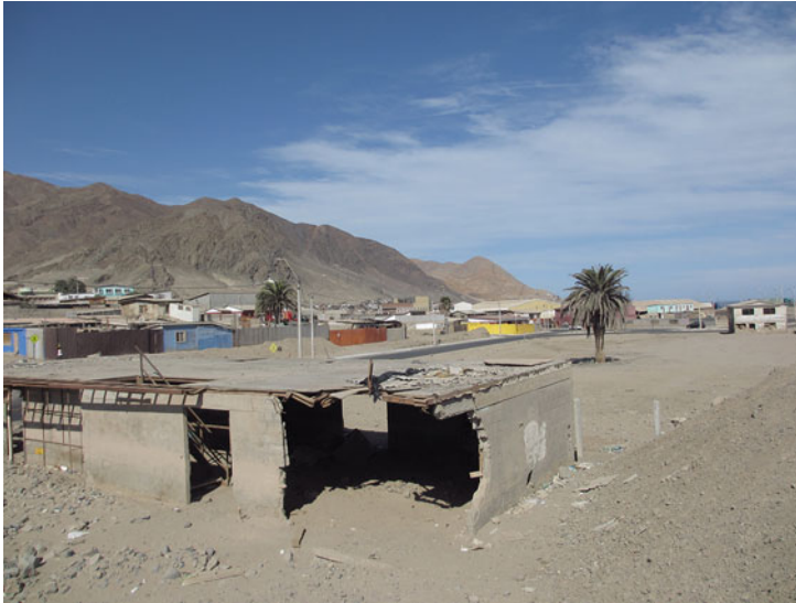
Abbildung 8.4 Zerstörte Gebäude nach den Überschwemmungen. (Quelle: Eigenes Foto, 3. April 2019 in Chañaral)
