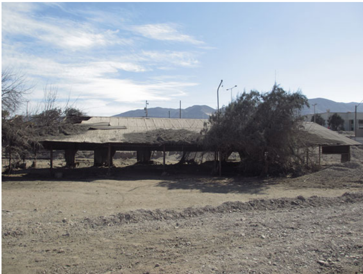
Abbildung 8.2 Zerstörte Gebäude nach den Überschwemmungen. (Quelle: Eigenes Foto, 3. April 2019 in Chañaral)
