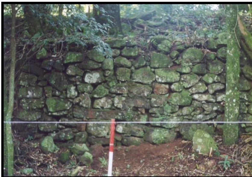
Fig. 5: Muro de contención del núcleo constructivo principal, hacia el jardín de los jesuitas. Fuente: Poujade
