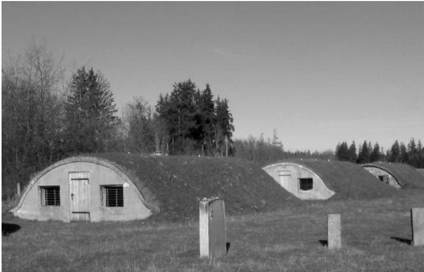
Abb. 2: Die drei Tonröhrenbaracken nach den 2016 abgeschlossenen Konservierungsmaßnahmen. Im Vordergrund links Schildwand und Fundamente einer Tonröhrenbaracke mit eingestürztem Gewölbe, November 2016. Quelle: Fotosammlung Manfred Deiler, Landsberg am Lech.
