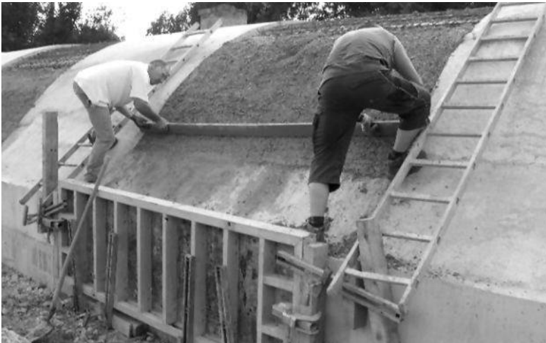
Abb. 4: Anbringung einer das Tonröhrengewölbe von außen stabilisierenden Betonschale im Zuge der Konservierungsmaßnahmen, Juni 2014 Quelle: Fotosammlung Manfred Deiler, Landsberg am Lech.
