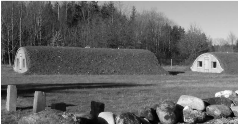
Abb. 2: Außenansicht Tonröhrenbaracken auf dem ehemaligen KZ-Gelände Kaufering VII, 2016. Quelle: Archiv Manfred Deiler, Europäische Holocaustgedenkstätte Stiftung.
