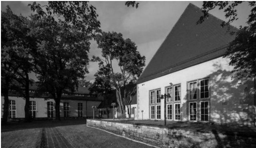
Abb. 4: Westliche Rückseite des Offizierskasinos mit Großterrasse, 2017. Quelle: Eckhart Matthäus.
