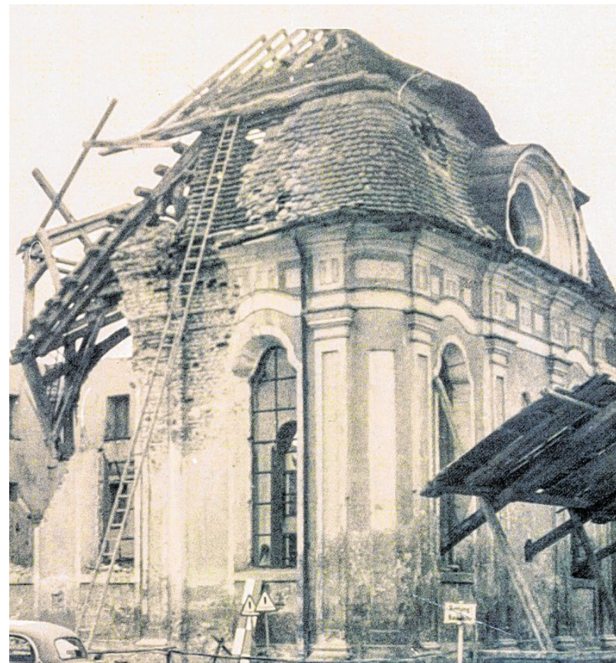
In Altenstadt wurde 1802 die Synagoge der jüdischen Gemeinde erbaut. Sie wurde im Jahr 1938 bei der Verfolgung unserer jüdischen Mitbürgerinnen und -bürger beschädigt und 1955 abgebrochen.
