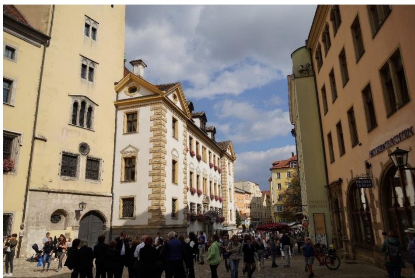
Abb. 28: Östlicher Rathausplatz in Regensburg mit den Untergeschossen des Rathausurmes links, daneben Barockanbau und gegenüberliegende Bebauung (aus: Privatfoto Christian Schaller, 2022)
