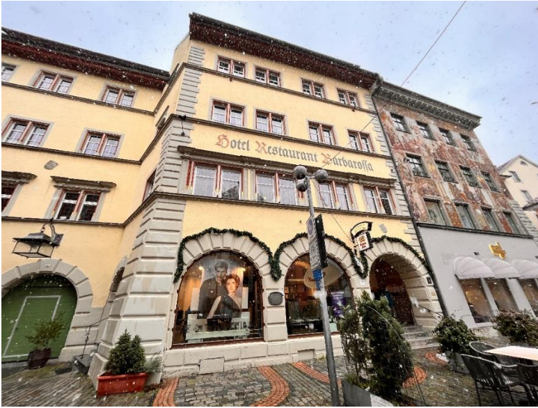
Abb. 81: Nördliche Bebauung des Obermarktes in Konstanz (aus: Privatfoto Christian Schaller, 2022)
