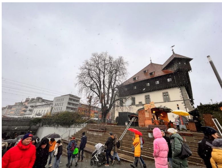
Abb. 91: Konstanzer Konzilgebäude mit davorliegender Unterführung in Richtung der Altstadt, während Nutzung des Areals als Weihnachtsmarkt (aus: Privatfoto Christian Schaller, 2022)
