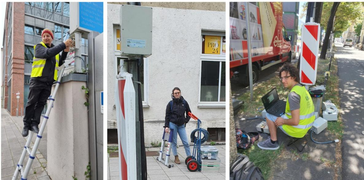
Abbildung 8: Wartung und Reparatur eines Messsystems (links); Material- und Werkzeugtransport (mitte); Messboxkontrolle und Datenauslese während einer Vergleichsmesskampagne (rechts).
