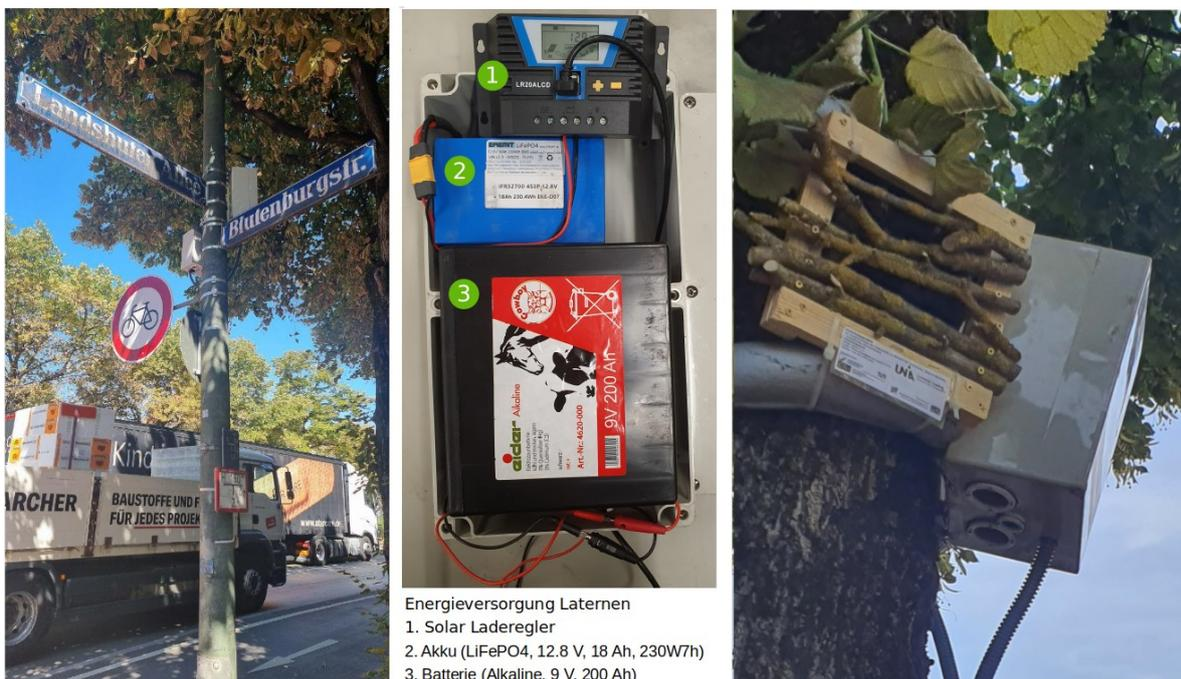
Abbildung 6: Stromversorgung mittels Akku und Pufferbatterie an Laternen-Standorten (links und mitte); Rahmen zur Flechten Bioindikation an low-cost Messstandort (rechts).
