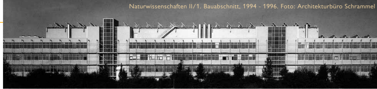
Was die Architekten im Laufe der letzten drei Jahrzehnte auf dem Augsburger Campus geschaffen haben ...
