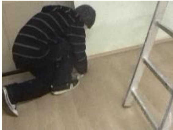
Abb. 46: Furkan beim Installieren seiner Arbeit
