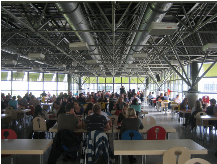
Abb.5-7: Die Mensahalle vor und nach dem Umbau (2008 und 2012). Vor den Umbauarbeiten sorgten v.a. die Fensterfronten für Tageslicht. Durch den Einbau von Lichtpyramiden und -kuppeln präsentiert sich der Raum nach Abschluss der Arbeiten durchgängig wesentlich heller. Die Maßnahmen sind Bestandteil eines umfassenden Lichtkonzepts des Ingenieurbüros Bartenbach, das unter anderem auch die gleichmäßige Verteilung von Licht mittels Reflektoren beinhaltet (siehe Abb.7).
