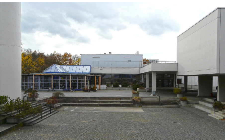
Abb. 26, 27: Details: Materialien vor der Sanierung: Holzverschalte Decken und Wände, n.d.
