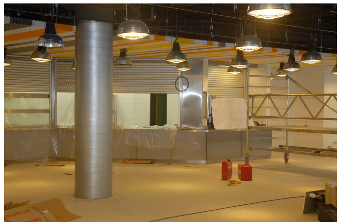
Abb. 52: Mensa Universität Augsburg, sanierte Cafeteria kurz vor der Wiedereröffnung (2012).
