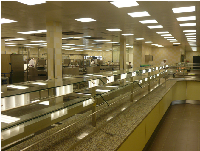
Abb. 57: Mensa Universität Regensburg, Ausgabebereich Großer Mensasaal (2011)
