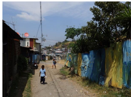
Abb. 12: La Carpio – Substanz der Wohnbauten (II)
