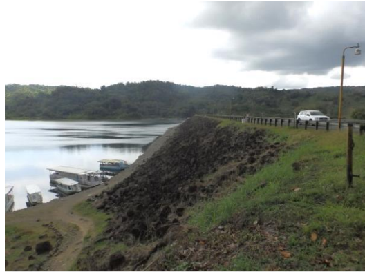
Abb. 62: Arenal-See – Ostufer mit Staudamm
