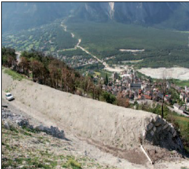
Abb.92: 3m-hoher Schutzdamm oberhalb von Leuk (WOHLGEMUTH ET AL. 2010)
