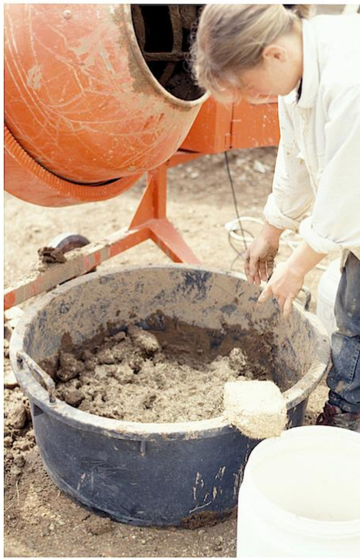
Abb. 7: Herstellung von Lehmziegeln, Murlo. Prüfung der Tonmischung.
