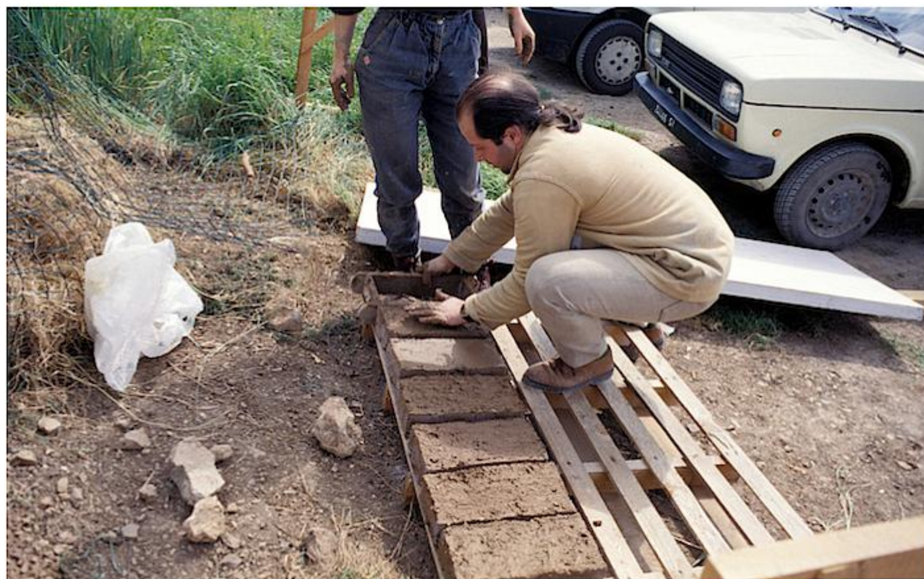
Abb. 9: Herstellung von Lehmziegeln, Murlo. Die Ziegel werden aus der Holzform gedrückt und auf Lattenrosten ausgelegt, bevor sie mit einer Plastikfolie überdeckt werden.
