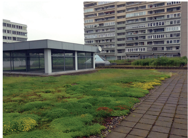
Abb. 6: Dachfläche Schwabencenter Mitte
