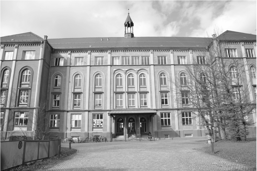
Abb. 4: Mittelbau von Süden, 2018. Quelle: Privatbild, Jana Schwindel.
