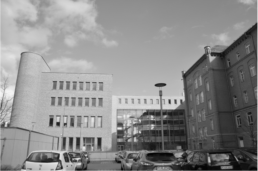
Abb. 3: Neubau des Gesundheitsparks Vincentinum, Wulf Architekten, 2018. Quelle: Privatbild, Jana Schwindel.
