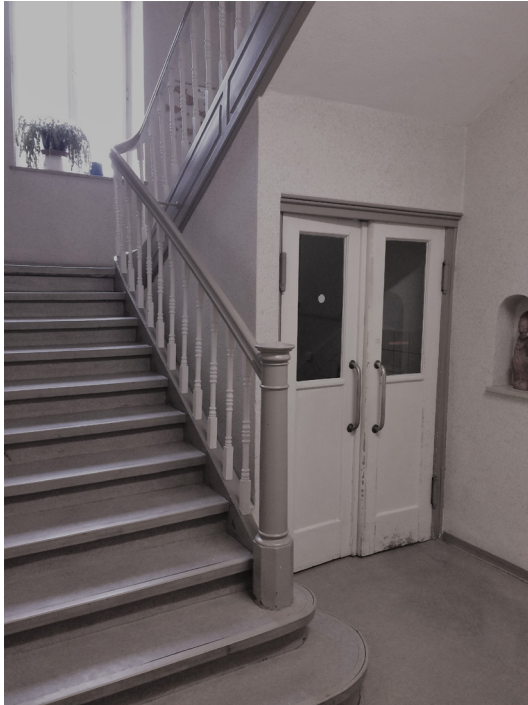
Abb. 8: Innenansicht des Staatlichen Schulamtes der Stadt Augsburg. (Der Treppenaufgang wurde seit dem Bestehen des Wöchnerinnenheims keinen größeren Renovierungen mehr unterzogen.) Quelle: Privatbild, Simone Steuer (14.03.2018).
