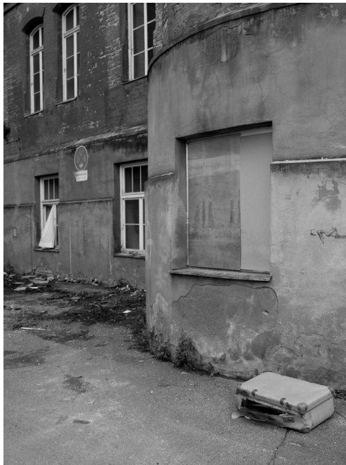
Abb. 2: Der desolante Zustand des Hauptkrankenhauses im Jahr 2010. Quelle: Privatbild, Jana Schwindel.
