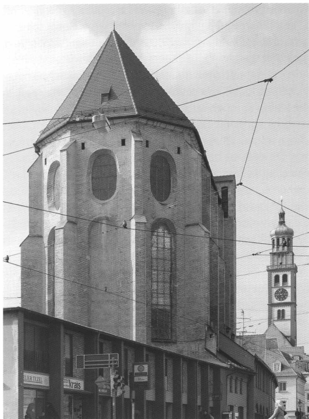
Abb. 1 Chor der Barfüßerkirche von Osten, 1411, ab 1946 wiederhergestellt.
