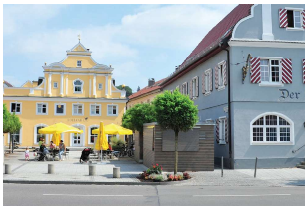
Abb. 1 Sanierte Bausubstanz im Zentrum von Thannhausen. (Foto: Hartmuth Basan)
