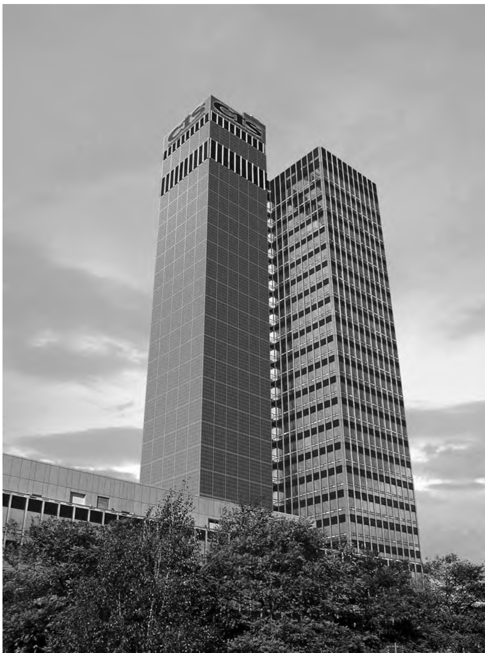
Abb. 3 Gebäudeintegrierte Photovoltaik: Der CIS-Tower in Manchester (Quelle: BSW Solar/Sharp)
