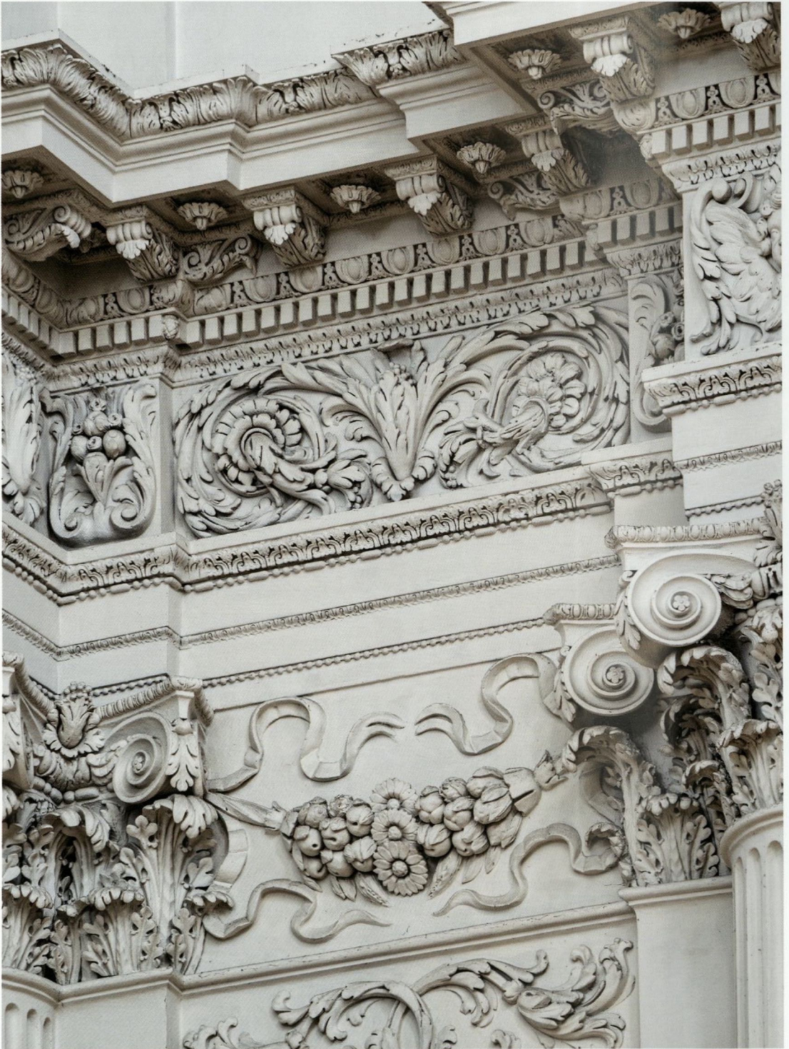
Abb. 4: Detail der Stuckdekoration, Aufnahme: 2015.
