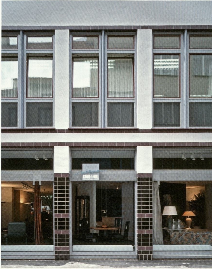
Abb. 23 Geschäftshaus Zeuggasse 7, Fassadenausschnitt, Foto 1993
