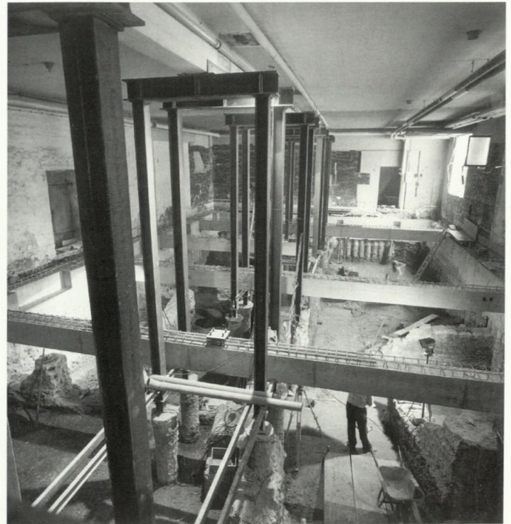
Abb. 26 Diözesanmuseum St. Afra, Augsburg, Unterfangung der alten Kapitelbibliothek, Foto um 1992
