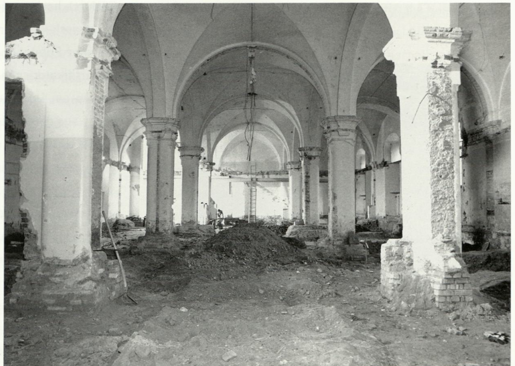
Abb. 5 Heilig-Geist-Spital, Blick in die Erdgeschosshalle nach Abbruch der Zwischenwände, Foto 1998
