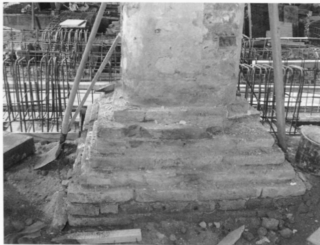
Abb. 7 Heilig-Geist-Spital, freigelegter Rundpfeilerfuß mit historischem Fundament, Foto 1998
