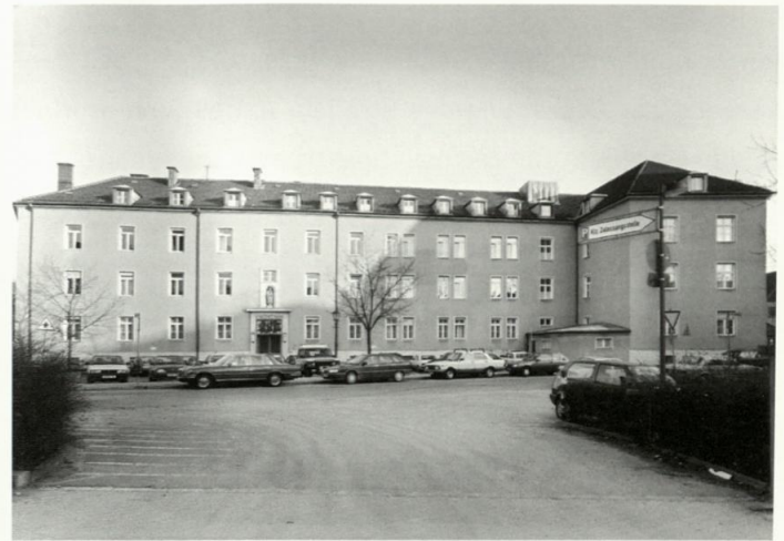
Abb. 11 Klinik Vincentinum, Augsburg, Vorgängerbau vor dem Abbruch 1996, Foto um 1990
