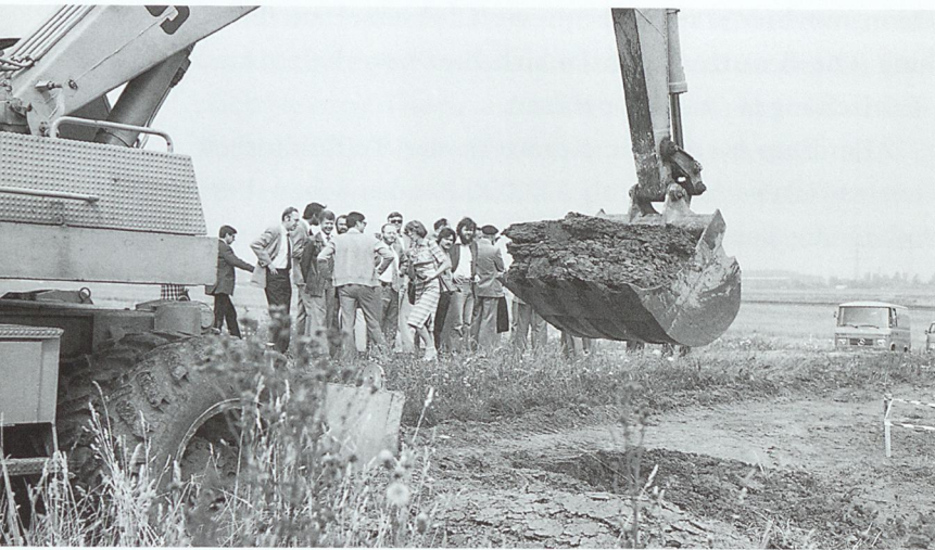
Abb. 2: Bodenaushub für die Zentralbibliothek, 1980.
