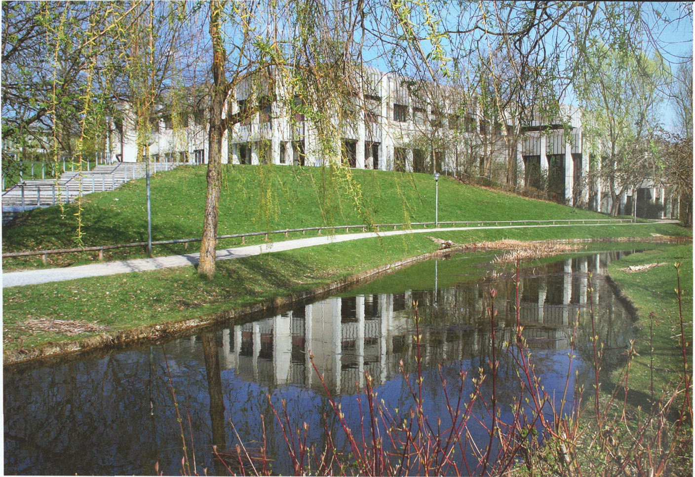
Abb. 5: Blick vom Campus auf die Zentralbibliothek.
