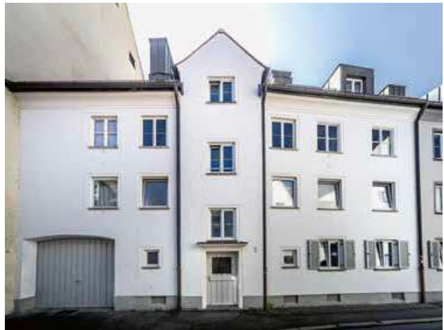
1 Erstes Augsburger Findelhaus, Findelhausgässchen 6, Augsburg 2021
