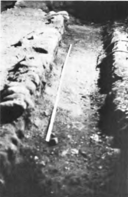
Fundament des Vorgängerbaues von St. Wolfgang
