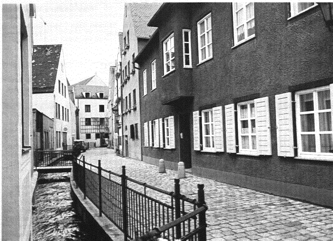
Bachaufdeckung und Modernisierung am "Hinteren Lech"
