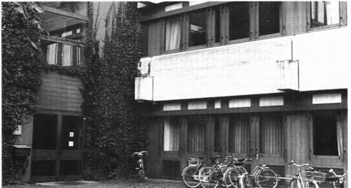
Die Oberflächenbeschaffenheit des Sichtbetons ist ein Negativabdruck der Schalung.
