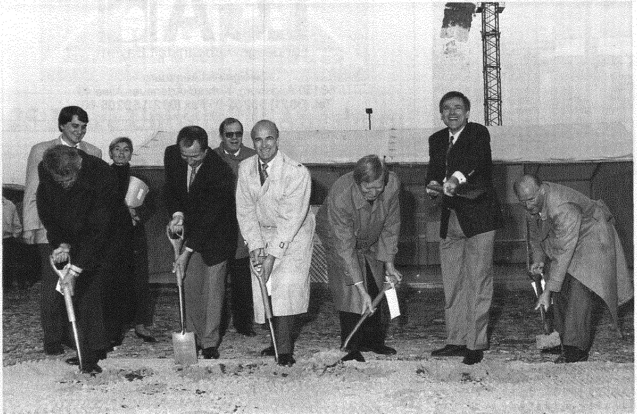
Die verschiedenen Möglichkeiten der Handhabung eines Spatens demonstrierten am 24. Oktober auf dem Physik-Gelände v. l. n. r.: der Leiter des Land- und Universitätsbauamtes, Baudirektor Bernhard Schwarz, der Baubeauftragte und derzeitige Prodekan der Mathematisch-Naturwissenschaftlichen Fakultät, Prof. Dr. Bernhard Stritzker, Augsburgs OB Dr. Peter Menacher, Kultusminister Zehetmair, Justizstaatssekretär Bernd Kränzle und Rektor Prof. Dr. Reinhard Blum. Foto: Hagg
