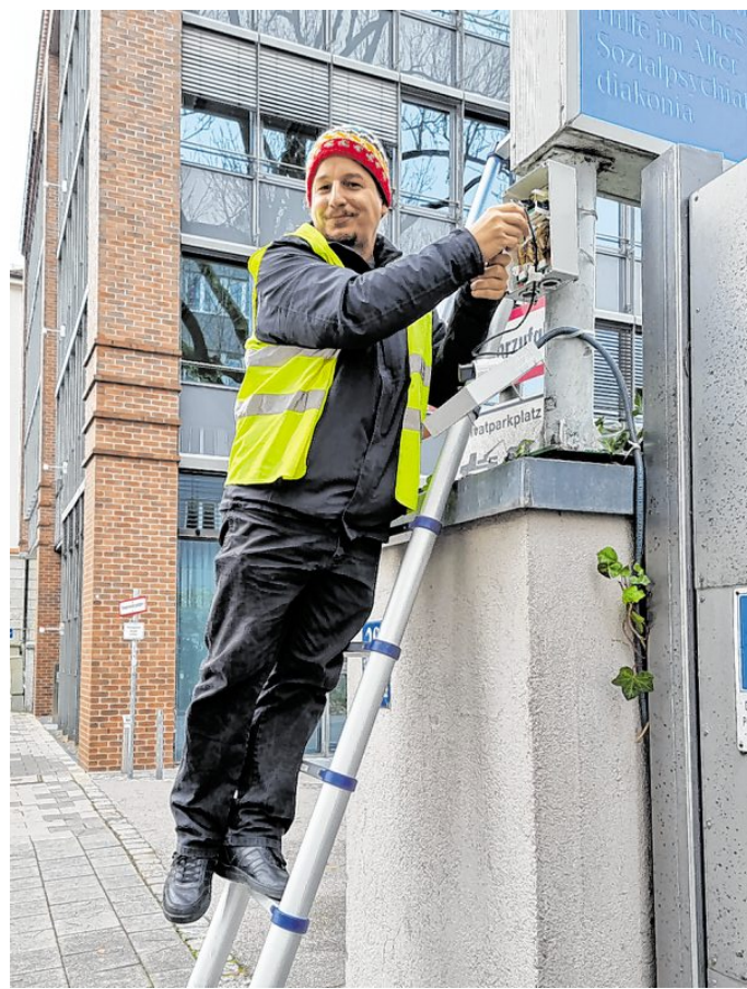
Montage einer Messbox an der Ostseite der Landshuter Allee.
