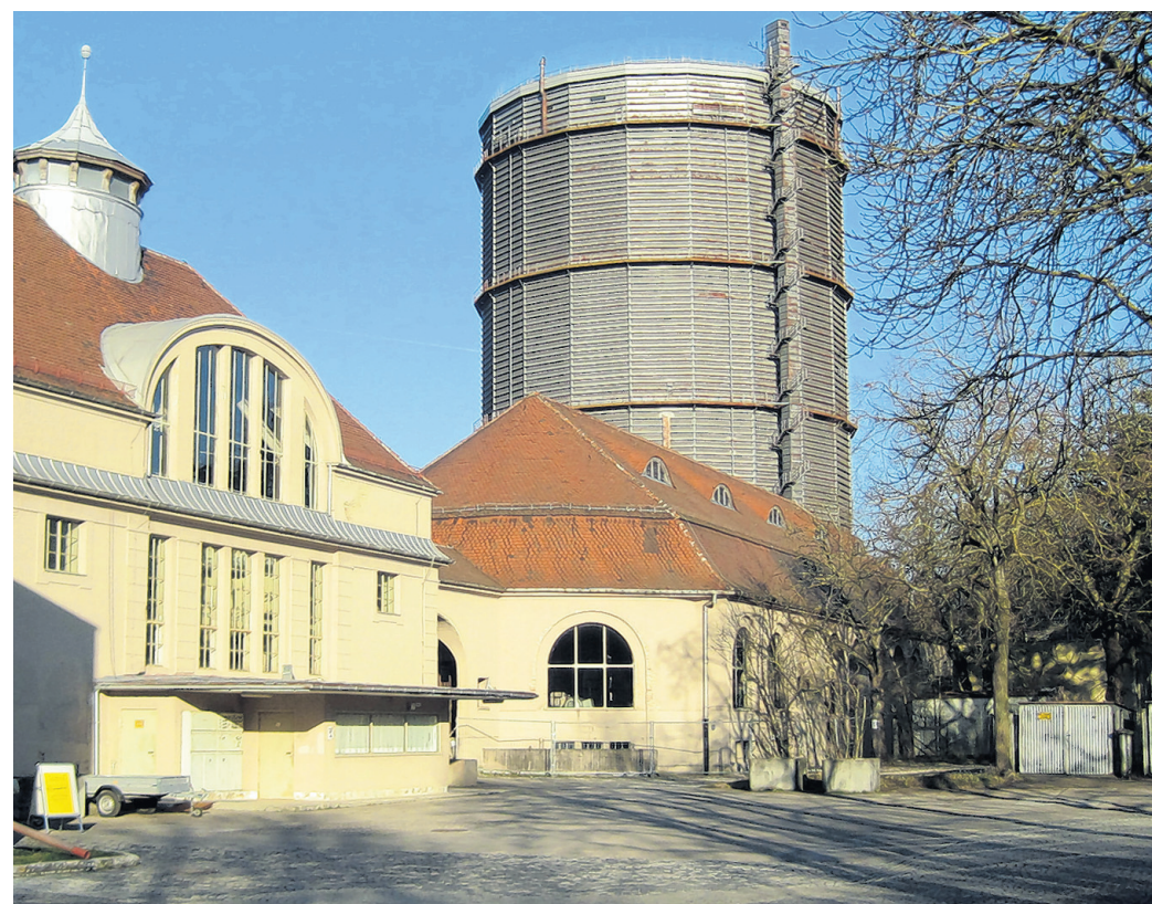
Der Gaskessel ist das markanteste Bauwerk des Gaswerks, über dessen Nutzung als Kreativ- und Kulturquartier Tobias Michl forscht.
