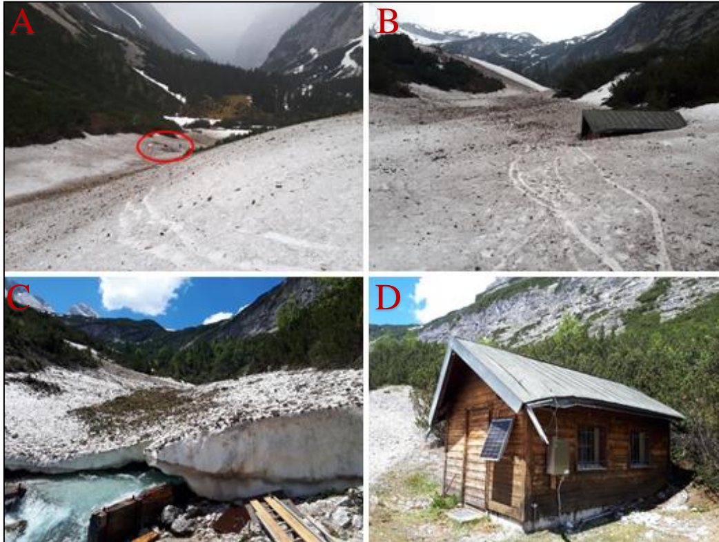
Abb. 21: Lawinenereignis im Frühjahr 2019. Lawinenschnee bedeckt die Pegelmessstelle (in Bild A markiert) und beschädigt das Generatorhaus (Bild B), wo sich Speichermodule befinden. In Bild A ist von der Ferne nur noch das Dach der Hütte innerhalb des roten Kreises zu erkennen. Einen Monat später ist die Pegelmessstelle immer noch durch den Lawinenschnee bedeckt (Bild C). Die verursachten Schäden sind an der Hütte deutlich erkennbar (Bild D), wo die vier Enden der Fußpfetten durch die Schneelast abgeknickt wurden.
