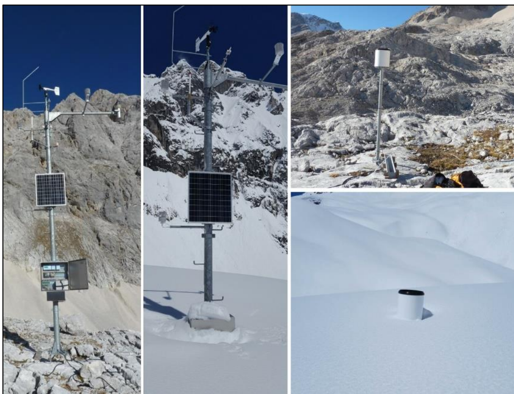
Abb. 17: Meteorologische Station Nord im Sommer und Winter. Der Schaltschrank mit der Batterie und den Logger- und Datenkommunikationseinheiten sowie die Niederschlagswippe sind durch die starken Schneefälle fast vollständig von der Schneedecke eingehüllt.
