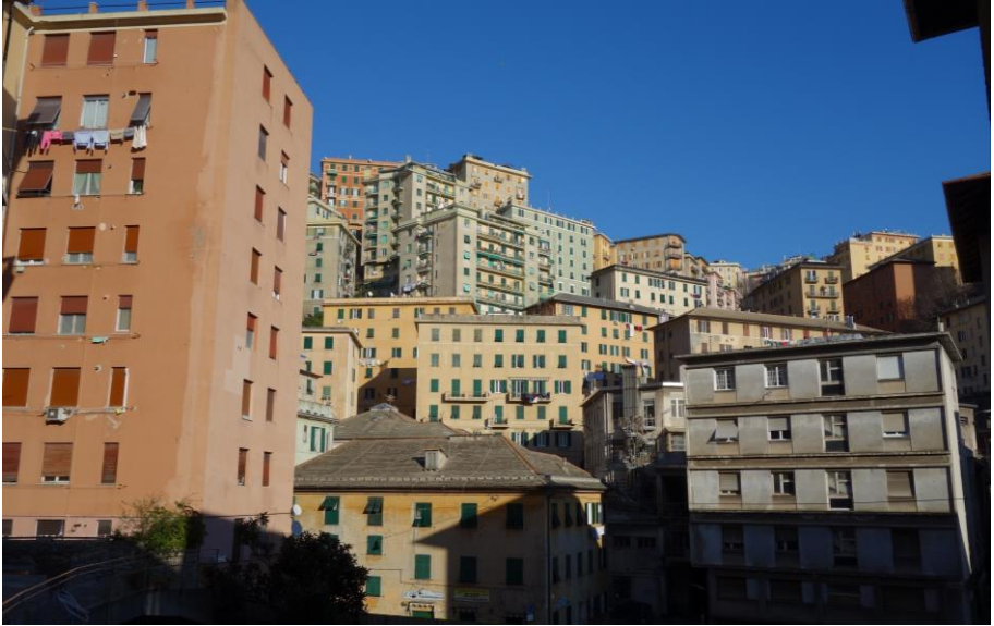
Abb. 10: Mehrfamilienhäuser im Viertel Lagaccio
