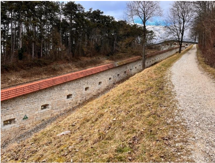
Abb. 73: Wallanlagen der ehemaligen Bundesfestung Ulm, rechts im Hintergrund Wilhelmsburg (aus: Privatfoto Christian Schaller, 2022)
