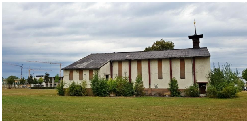
Abb. 24: Ehemalige Chapel in Sheridan Park in Augsburg (aus: Privatfoto Christian Schaller, 2022)
