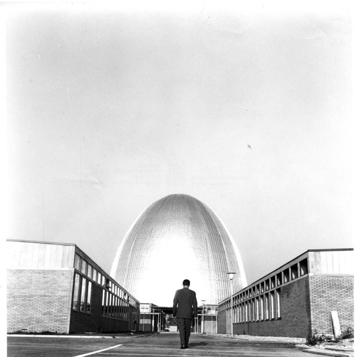
Das sogenannte Atom-Ei in Garching: Die Kuppel ist mit Aluminium umkleidet.
