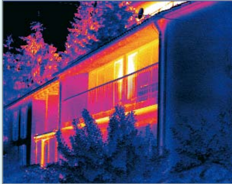
Aufnahme mit einer Wärmebildkamera. Die Entwicklung des Gebäudestandards hat wesentlichen Einfluss auf den Energieverbrauch.
