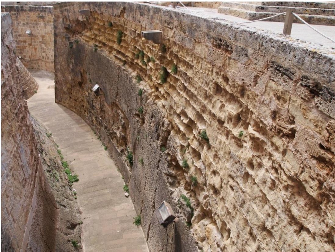
ABBILDUNG 46: VERWITTERUNGSPUREN IM SANDSTEIN AM GRABEN DES CASTELL DE BELLVER
