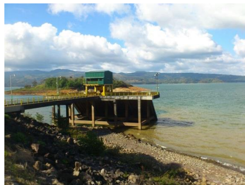
Abb. 64: Einlassröhre des Kraftwerks an der Westseite des Arenalsees mit Reinigungsrampe
