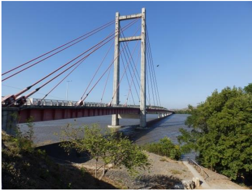
Abb. 44: Puente de la Amistad über den Río Tempisque
