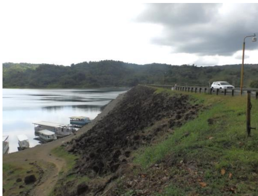
Abb. 62: Arenal-See – Ostufer mit Staudamm
