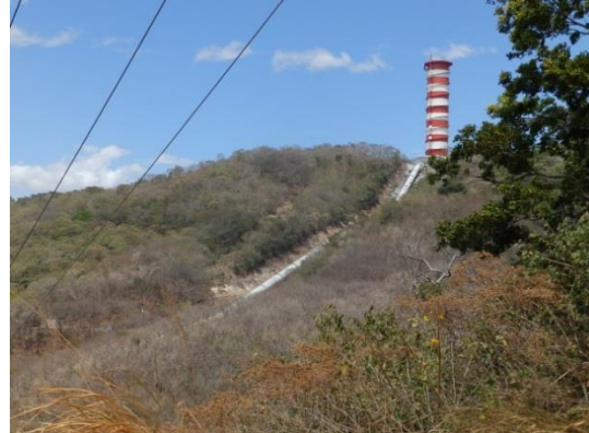
Abb. 60: Türme als Wasserschlösser für die Stollen des Arenalseewassers (Überleitung in die Gegend von Cañas)
