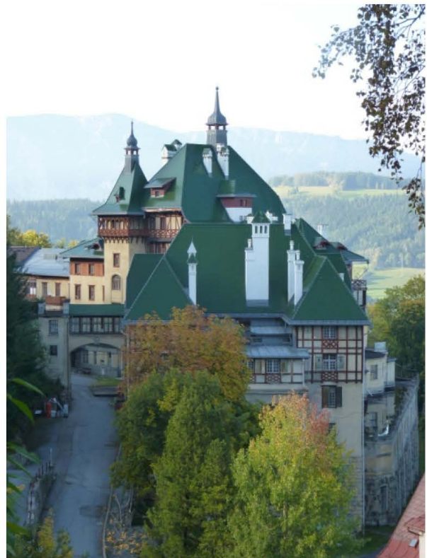
Abbildung 55: Das leerstehende Südbahnhof mit Blick zur Rax
