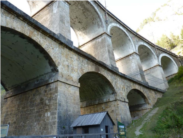
Abbildung 54: Das Viadukt 'Kalte Rinne' (Semmeringbahn)
