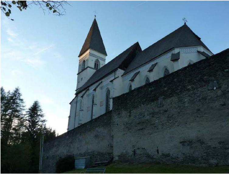
Abbildung 32: Gotische Wehrkirche bei Grades
