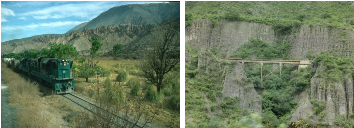
Abb. 180 a und b: Gütertransport auf der Trasse des 'Tren a las Nubes' (li.); das Tal ist in der Quebrada del Toro in alte fluviale Aufschüttungen eingetieft, was die Trassenführung erschwert (re.)
