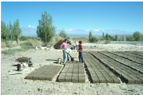
Abb. 89: Adobeziegel-Herstellung (bei Tamberías )
