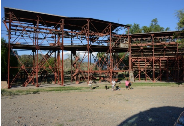
Abb. 118 a und b: 'Cablecarriil' (Chilecito) – Endstation (Verladung auf die ehemalige Eisenbahn) und Stützen der auf die Sierra de Famatina hinaufführenden Erz-Seilbahn
