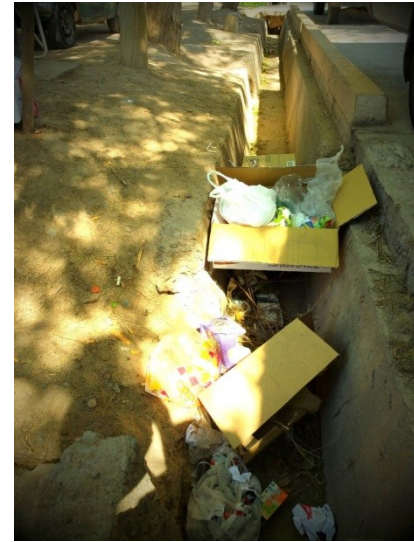
Abb. 48: Straßenszene in Costa de Araujo ; begleitend zur Straße ' Acequias ' zur Bewässerung und Ableitung des Niederschlagswassers bei Starkregen.
