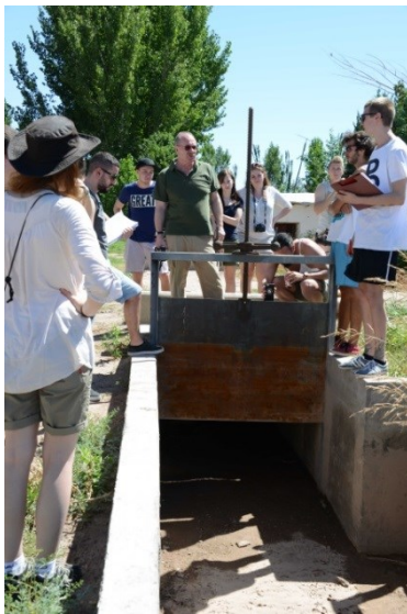
Abb. 52: Frisch erneuerter Bewässerungs- Zuleitungskanal nördl. Ingeniero Gustavo André
