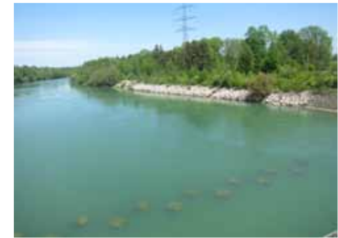
Lechlandschaft modern: Dämme, Masten, Flussbausteine, 2012 (Foto Jens Soentgen).
