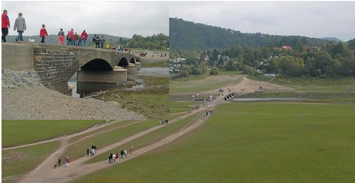
Abb. 1 Das Dorf Asel, gegründet 1317, erbaute 1890 diese Brücke. Wegen des Baus der Edertalsperre wurde das Dorf umgesiedelt und 1914 geflutet. Durch den Jahrhundertsommer senkte sich der Wasserspiegel im Jahr 2003 soweit, dass neben vielen versunkenen Bauruinen auch diese gut erhaltene Brücke wieder ans Tageslicht trat. (Foto und Text von Matthias Heitwerth)
