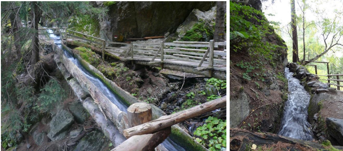
Abb. 49 u. 50: Der Berkwaal oberhalb Schluderns – In h lzerne "Kandeln" verlaufende (links) und mit Steinen gefasste (rechts) Abschnitte. Photo: Schneider (2017)
