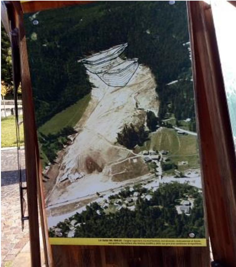
Abb. 108: Dokumentationstafel mit Foto des Damnbruchs in Stava – oberes und unteres Absetzbecken und Weg der Schlammmassen.
