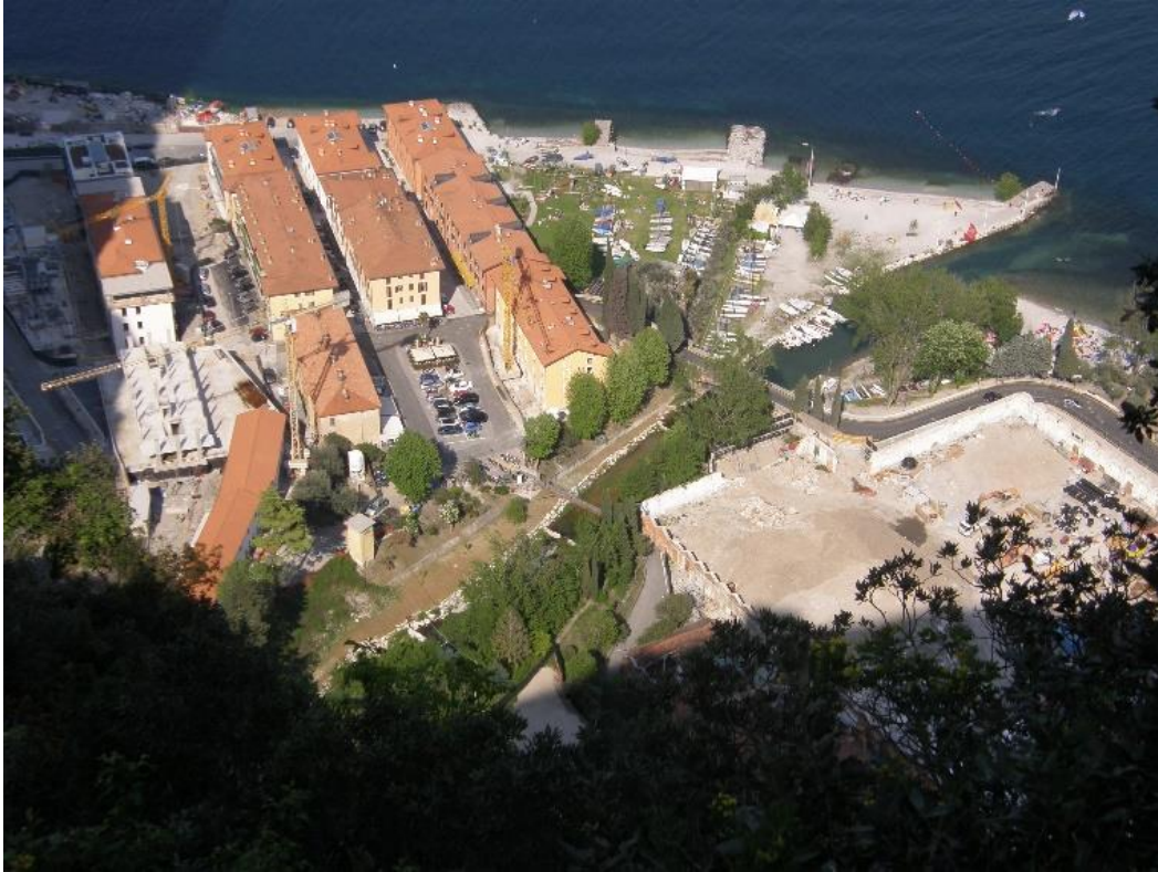
Abb. 123: Blick auf Campione vom Weg hinauf nach Pregasio – Die alten Arbeiter-Wohnblocks sind noch zu sehen, Neubauten werden gerade errichtet; die Fabrikgebäude sind bereits weitgehend dem Abbruch anheimgefallen. Photo: Schneider (2009)
