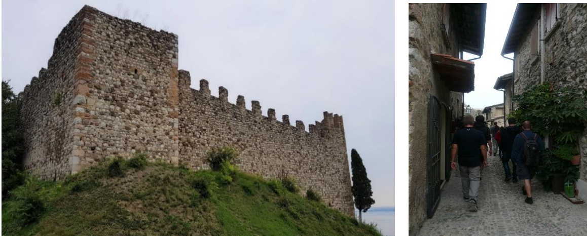
Abb. 135: Castello di Padenghe – charakteristische bunte Mauer aus Moränenblöcken des Gardaseegletschers mit mittelalterlichen Schwalbenschwanzzinnen.
