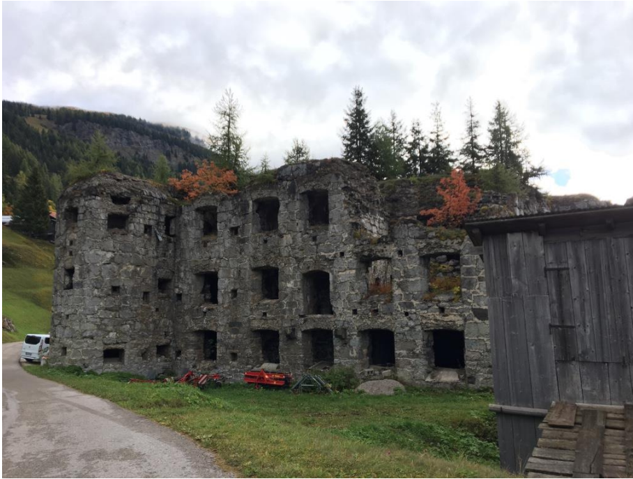
Abb. 162: Ruine des "Werks Corte" bei Chertz. Photo: Eigene Aufnahme d. Verf. (2017)
