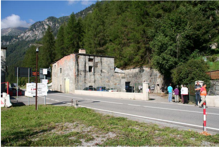
Abb. 54: Altösterreichisches Sperrwerk bei Trafoi. Photo: Schneider (2013)
