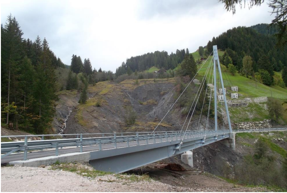
Abb. 173: Neue Brücke im Rutschungsgelände "Josciara" an der Zufahrt zum Weiler Costa. Photo: Schneider (2012)
