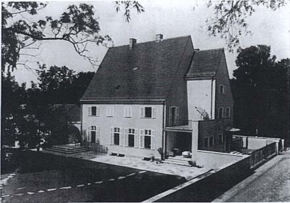
Anhang B: Nr. 10a: Anwesen Familie Bleckers, Haushoferstr. 3 in München-Bogenhausen. Links hinter den Bäumen der Atelier-Anbau.
